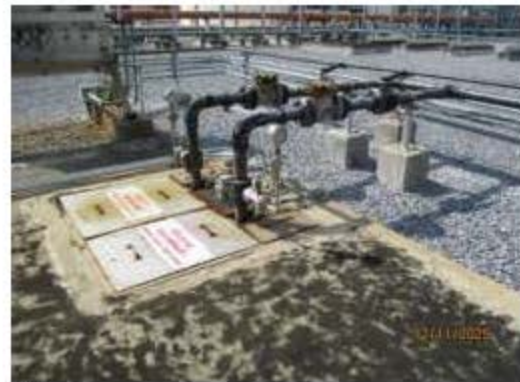
ภาพที่ 2.2-10 บ่อตรวจสอบคุณภาพน้ำทิ้ง พร้อมมวลวาล์ว ของโรงไฟฟ้า
